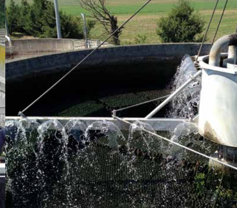
Percolatore per settore alimentare con moduli TFM27 (PR) Trickling filter for food industry with TFM27 modules (Parma - Italy)
