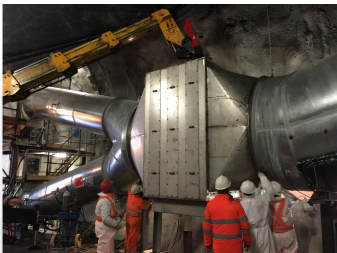
Sistema di rimozione gocce per un impianto di aspirazione aria all'interno di una galleria
