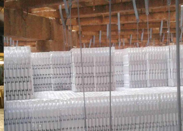
Un esempio di progettazione finalizzata alla fornitura. Questa torre iperbolica è stata ripotenziata con il prodotto FMV21 in PVC LT (bassa temperatura). Il team tecnico ha dimensionato la sezione di riempimento per fare in modo di avere una resa superiore rispetto a quella precedente.
