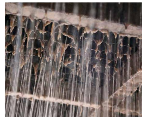
La filtrazione biologica è quel processo di ossidazione aerobica attraverso cui i cataboliti prodotti dall'attività metabolica dei pesci vengono trasformati in composti non tossici, tramite il biofilm che si viene a creare sul supporto.
