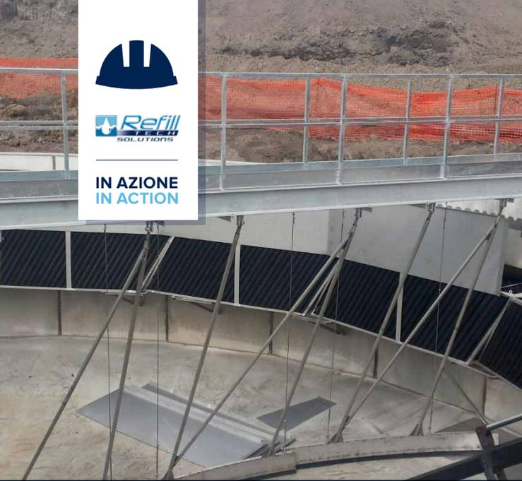
Sedimentatore circolare con LSM50 (PR)
