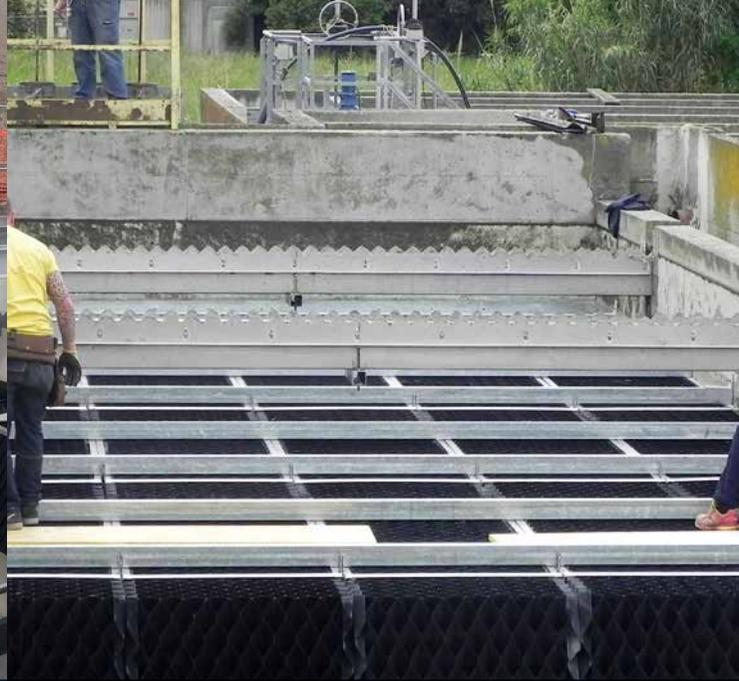
Sedimentatore secondario con LSM60 (MC)
